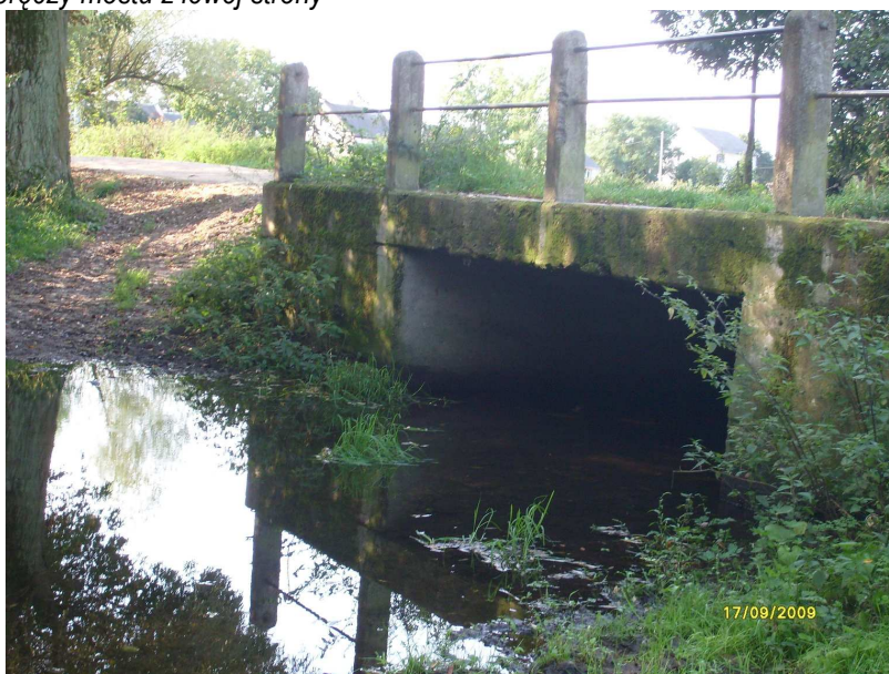
Zdjęcie 2: widok płyty mostu od strony górnej wody
