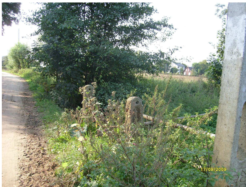
Zdjęcie 3: widok poręczy mostu z prawej strony
