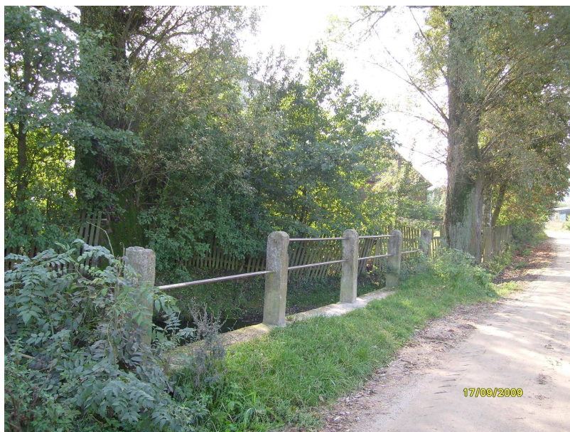
Zdjęcie 1: widok poręczy mostu z lewej strony
