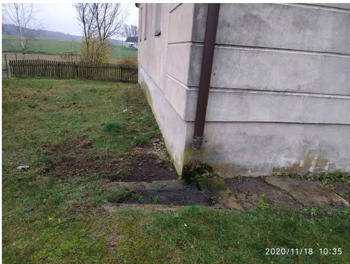
Inwentaryzacja – brak kolan wylewowych z rur spustowych
